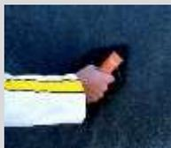
La finition peut se réaliser avec une taloche ou une éponge selon la texture visée. Pour assurer une maturation correcte il est très important humidifier la surface imperméabilisée passées 24 heures après son application et répéter cette opération 4 jours durant.
