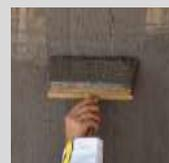
Humidifier la première couche et appliquer une seconde passe croisée par rapport à la première, de la même consistance que la première, pour garantir les 3 kg/m<sup>2</sup> de couche minimale. Pour assurer une maturation correcte il est très important humidifier la surface imperméabilisée passées 24 heures après son application et répéter cette opération 4 jours durant.
