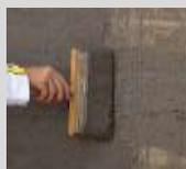
Appliquer **weber.tec imper F** en deux couches, utilisant une brosse ou taloche sur le support humidifié. Appliquer une première couche, au minimum, 1mm d'épaisseur (1,5 kg/m<sup>2</sup>) et laisser sécher 4 heures.
