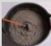
Gâcher avec un malaxeur électrique lent (500 tr/min), avec 6,25 – 6,75 litres d'eau propre par sac de, jusqu'à obtenir une masse homogène et fluide, avec consistance de l'eau.
