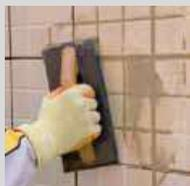
Remplir les joints avec une taloche en caoutchouc, en étalant le produit en diagonale par rapport aux joints, et en pressant la gâchée contre les joints. Enlever l'excès de matériel avec cette même taloche.
