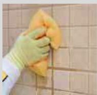
Une fois le durcissement initié, lorsque l'éclat superficiel du mortier à joints aura disparu (passées approximativement 45 - 60 minutes), il sera possible de le nettoyer avec une éponge humide. Le nettoyage final doit être fait avec le produit complètement durci (24 heures minimum), en essuyant la surface avec de l'eau propre ou passant un chiffon humide.
