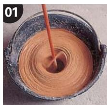
Gâcher **weber.cal fino** manuellement ou avec un malaxeur électrique pour obtenir une pâte fine, onctueuse et sans grumeaux. Compter 1,5 l d'eau par sac.
