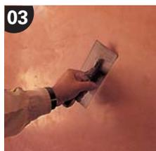
En lisant et polissant la couche de **weber.cal fino** avec une taloche d'acier inoxydable, on obtient une texture brillante, douce et soyeuse. Utiliser ruban adhésif pour marquer les joints de travail.
