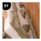
Gâcher weber.therm base avec 5,5 - 6,5 litres d'eau propre par sac, avec un batteur électrique. Appliquer un cordon weber.therm base de 4 - 8 cm de large et de 2 - 4 cm d'épaisseur sur le périmètre du panneau et 3 points au centre de ce dernier, puis procéder à sa pose sur le parement. La surface d'adhésion, une fois que le panneau est fixé au support, doit être au minimum de 40%.
