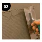
Lorsque les panneaux sont posés, que l'adhésif est sec, que les panneaux sont ancrés mécaniquement avec au minimum 6 goujons par m<sup>2</sup>, régulariser les panneaux avec une couche de 5 à 6 mm armée avec weber.therm malla 160.
