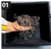
Gâcher avec les mains protégées avec des gants en caoutchouc une petite quantité du produit, qui pourra être utilisée en 1 minute (0,3 litres d'eau par kg).
