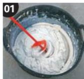
Gâcher **weber.tec glass** avec 5,5 - 6,5 litres d'eau propre par sac de 25 kg, manuellement ou avec un batteur électrique lent (500 t/mn), jusqu'à l'obtention d'une pâte homogène et sans grumeaux.
