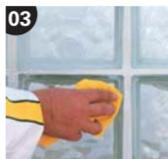
Armer la cloison avec des tiges en acier galvanisé de 6 mm de diamètre, sans que ces dernières soient en contact avec le verre. Procéder au lissage et à la finition, en retouchant avec un gant en plastique, une fois que le matériau aura commencé à durcir. Éliminer les traces de salissure avec un chiffon sec lorsque le mortier aura durci.
