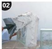
Appliquer la pâte sur le bloc de verre. Placer les pièces avec des croisillons, pour obtenir une largeur de joint régulière.
