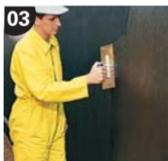
Après 3 heures, applique une seconde couche pour assurer une épaisseur finale de 3 mm minimum, selon l'application. Placer tissu de verre entre les deux couches de **weber.tec 915**, sur les parties qui sont soumises à la pression d'eau.
