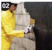
Laisser sécher pendant 10 minutes pour assurer l'absorption du support. Appliquer une première couche de **weber.tec 915** avec une taloche ou projeter, pour régulariser.
