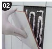
Comme joint flexible, après avoir calculé le joint et préparé la surface, extruder soigneusement sans créer de bulles d'air et pousser le mastic contre les sommets du joint. Il est recommandé de délimiter le joint avec un ruban adhésif de protection. Éliminer le ruban adhésif avant que le mastic ne commence à polymériser.
