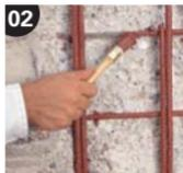
Appliquer **weber FR** à la brosse ou au pinceau sur les armatures propres en évitant, dans la mesure du possible, le contact avec le béton. Pour une bonne protection, **weber FR** doit être appliqué en deux couches épaisses (de 1 à 2 mm). Appliquer la seconde couche une fois que la première est sèche (environ 1 heure plus tard).
